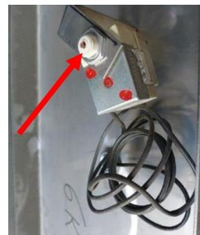
**Abbildung 77:** Thermostat mit freigelegtem Rückstellknopf
