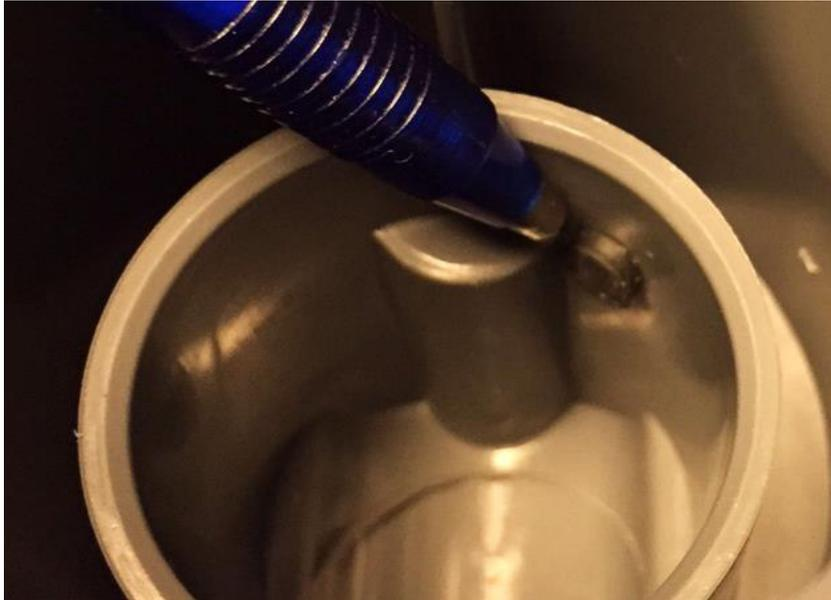
**Abbildung 72:** Druckseitige Installation: schwarzen Verschlussstopfen entfernen
