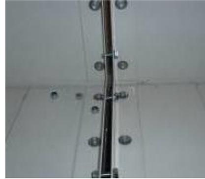
**Abbildung 31:** Verbindung mittels Einbauwinkel
