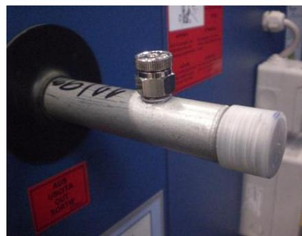
**Abbildung 66:** Entlüftungsventil
