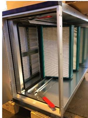
**Abbildung 50:** Reihenfolge laut Filterrahmenraster beachten
