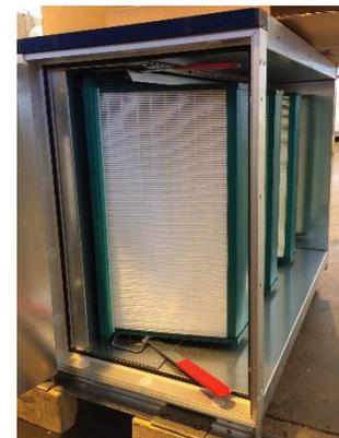
**Abbildung 51:** Filtersektion mit eingeschobenen Filtern
