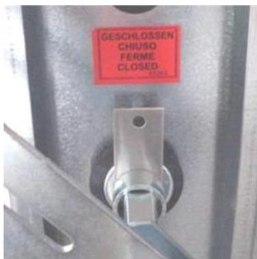
**Abbildung 43:** Schließstellung, gekennzeichnet durch eine Blechstellanzeige
