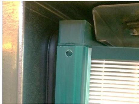
**Abbildung 53:** Kontrolle, ob Filter auf Dichtung aufliegt
