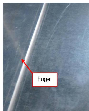
**Abbildung 37:** Abdichten der Geräteteilung (Fuge) mit Dichtmasse
