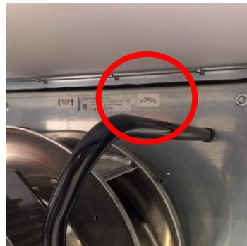
**Abbildung 74:** Drehrichtungskennzeichnung EC-Ventilator
