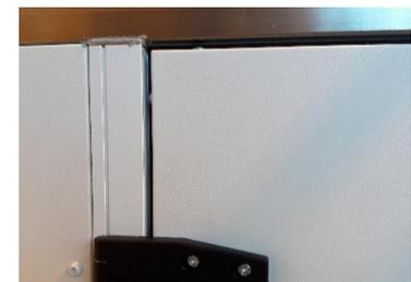
**Abbildung 132:** Justiert - gleichbleibende Spaltbreite (ZIS)
