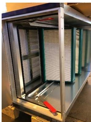
**Abbildung 157:** Reihenfolge laut Filterrahmenraster beachten
