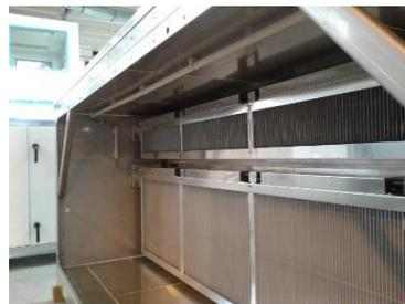
**Abbildung 169:** Elektrostatische Filter im Filterrahmen
