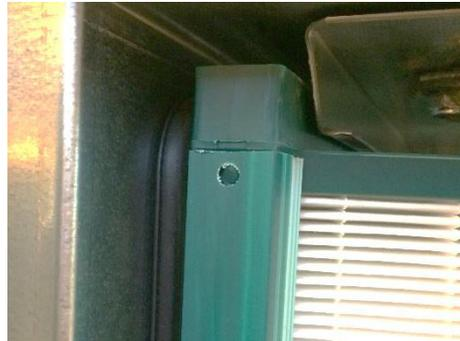
**Abbildung 160:** Kontrolle, ob Filter auf Dichtung aufliegt
