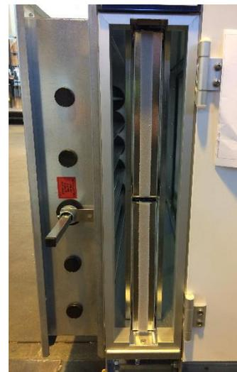
**Abbildung 136:** Türpaneel (TRA) entfernt
