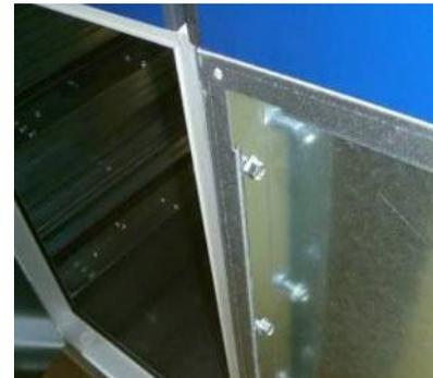
**Abbildung 78:** Verbindung Türrahmen / Innenpaneel
