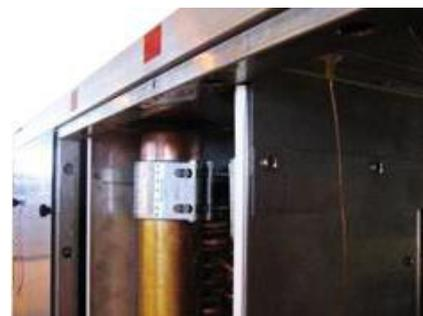
**Abbildung 179:** Montierte STRAUB Kupplung
