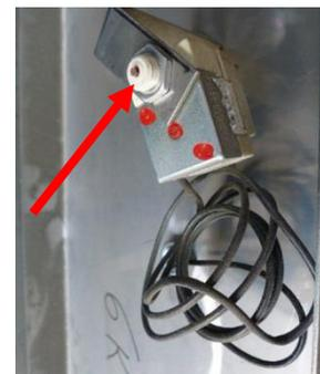
**Abbildung 212:** Thermostat mit freigelegtem Rückstellknopf
