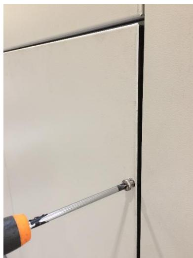
**Abbildung 138:** Türpaneel (TRA-E) von Türrahmen lösen
