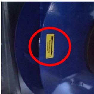
**Abbildung 206:** Drehrichtungskennzeichnung Freiläufer
