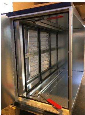
**Abbildung 156:** Filterrahmen für unterschiedliche Filtergrößen
