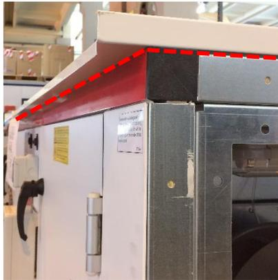
**Abbildung 111:** Fugen mit Dichtmasse schließen
