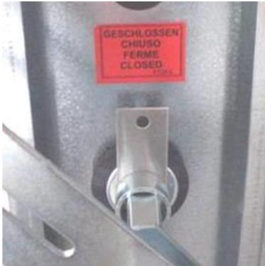
**Abbildung 145:** Schließstellung, gekennzeichnet durch eine Blechstellanzeige
