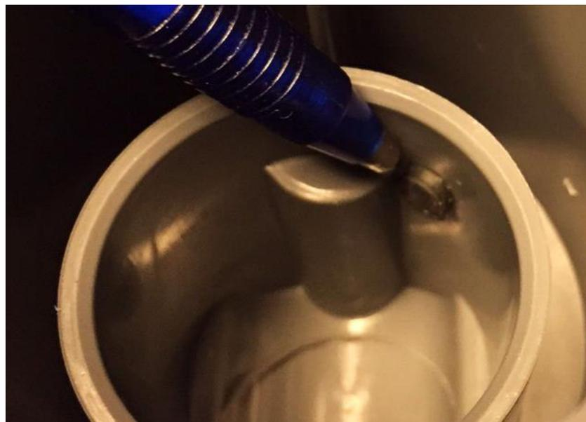
Abbildung 198: Druckseitige Installation: schwarzen Verschlussstopfen entfernen
