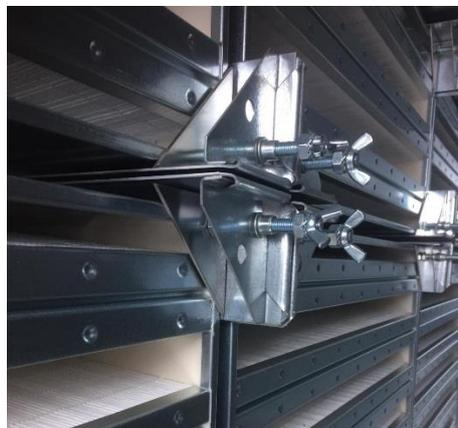
**Abbildung 165:** Filterspanner mit Andrückblech
