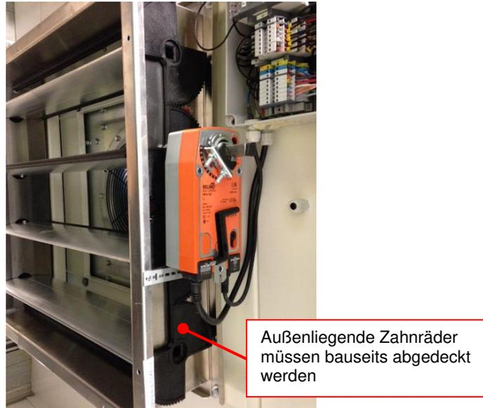
**Abbildung 171:** Klappe mit außenliegenden Zahnradern
