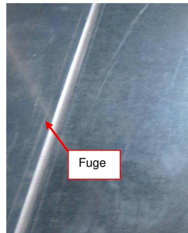
**Abbildung 102:** Abdichten der Geräteteilung (Fuge) mit Dichtmasse
