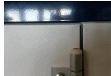
**Abbildung 129:** Justiert - gleichbleibende Spaltbreite (EU.T)
