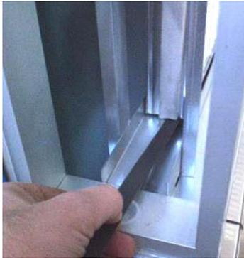
**Abbildung 147:** Ausziehen der Filter
