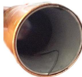
**Abbildung 177:** Kupferrohr mit eingesetztem Verstärkungsring
