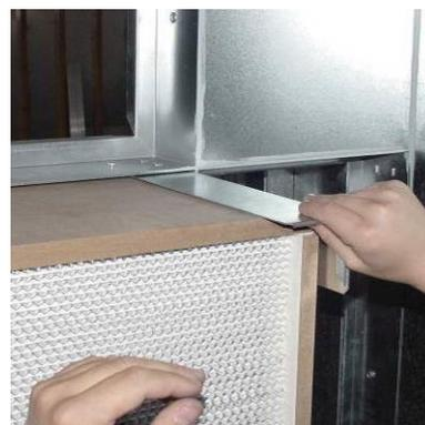
**Abbildung 162:** Filterzelle einführen
