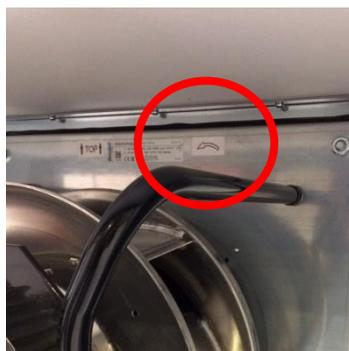
**Abbildung 208:** Drehrichtungskennzeichnung EC-Ventilator
