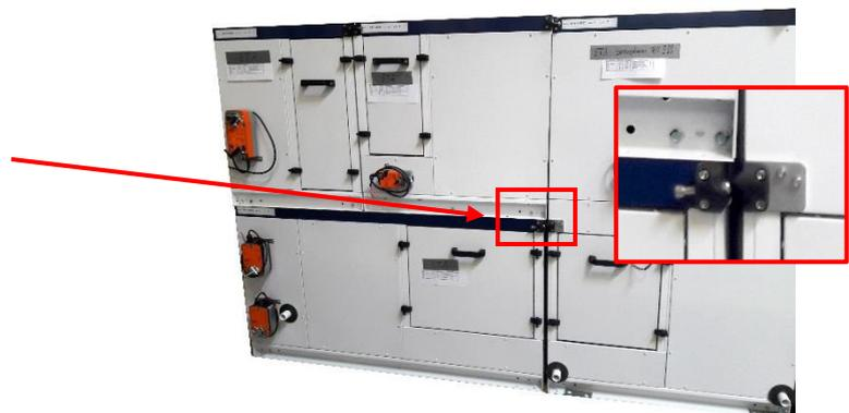
**Abbildung 68:** Montierte Easy connection bei doppelstöckigem RLT-Gerät
