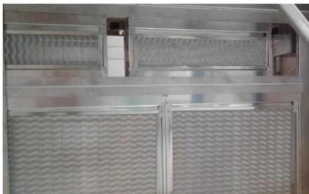
**Abbildung 168:** Montage elektrostatisch Filter
