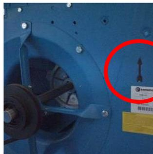
**Abbildung 207:** Drehrichtungskennzeichnung Gehäuseventilator
