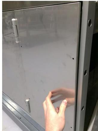
**Abbildung 60:** Außenpaneel mit gelösten Schrauben
