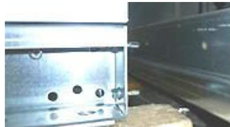
**Abbildung 80:** Bohrschraubenanwendung
