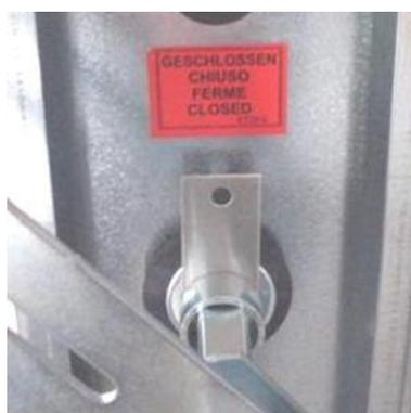
**Figura 43:** Posizione di chiusura, contraddistinto da un indicatore di posizione in lamiera
