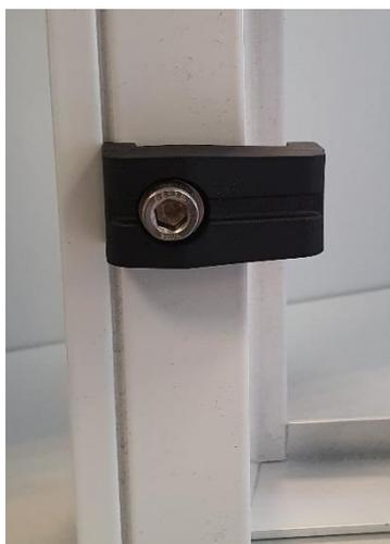
**Figura 41:** Meccanismo di fissaggio sul telaio della porta (ZIB)
