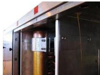
Figura 61: Giunto STRAUB montato
