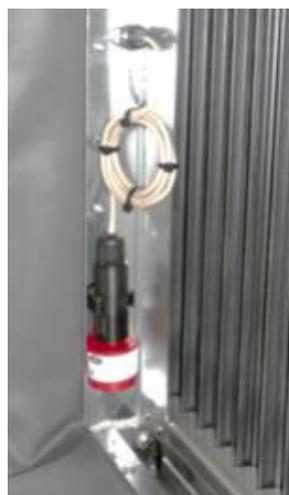
**Figura 56:** Sensore di gas montato
