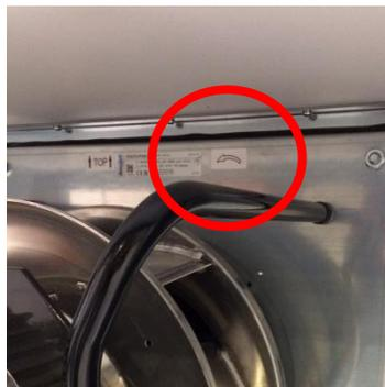
**Figura 74:** Identificatore della direzione di rotazione. Ventola EC
