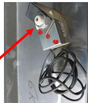
**Figura 77:** Termostato con pulsante di ripristino esposto
