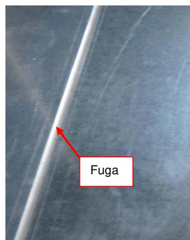
**Figura 37:** Sigillare la divisione delle sezioni (fuga) con la massa sigillante
