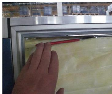
**Figura 47:** Fissare il filtro
