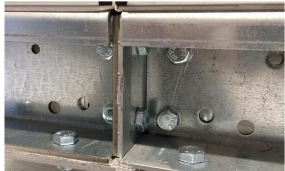
Figura 26: Avvitamento del telaio di base
