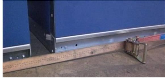
Figura 24: Unire le sezioni dell'UTA (dettaglio)
