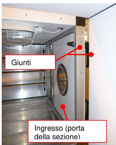
**Figura 36:** Divisione accessibile mediante porta dell'UTA
