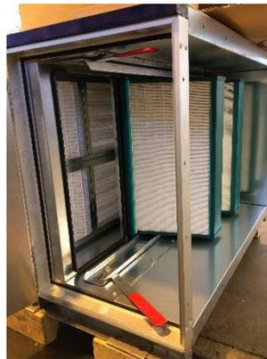
**Figura 50:** Prestare attenzione all'ordine in base alla griglia del telaio del filtro
