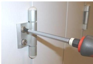
**Figura 128:** Regolazione del battente
