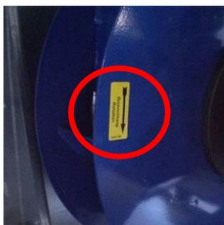
**Figura 206:** Marcatura senso di rotazione sulla girante libera
