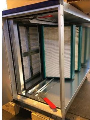
**Figura 157:** Prestare attenzione all'ordine in base alla griglia del telaio del filtro
