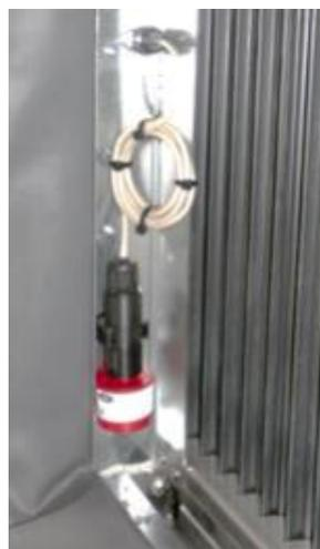
**Figura 174:** Sensore di gas montato
