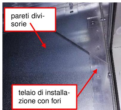
**Figura 91:** Telaio di montaggio e parete divisoria (non ancora avvitato)
