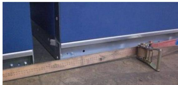
Figura 57: Unire le sezioni dell'UTA (dettaglio)
