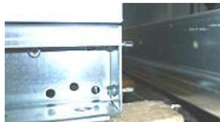
Figura 80: Applicazione viti perforanti
