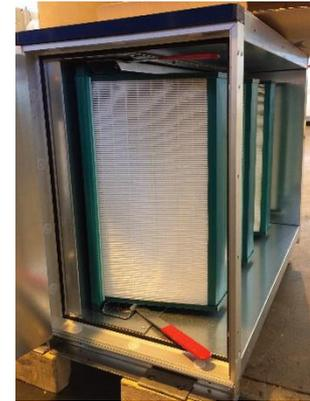
**Figura 158:** Sezione filtro con filtri inseriti
