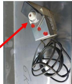
**Figura 212:** Termostato con pulsante di ripristino esposto
