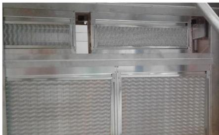
**Figura 168:** Montaggio di filtri elettrostatici
