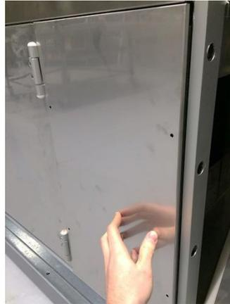
**Figura 60:** Pannello esterno con viti allentate
