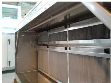
**Figura 169:** Filtri elettrostatici nel telaio del filtro
