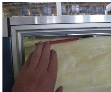
**Figura 154:** Fissare il filtro
