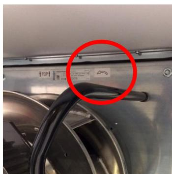
**Figura 208:** Identificatore della direzione di rotazione. Ventola EC
