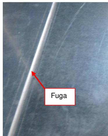
**Figura 102:** Sigillare la divisione delle sezioni (fuga) con la massa sigillante
