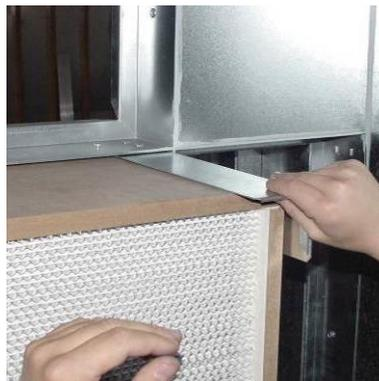
**Figura 162:** Inserire la cella filtrante
