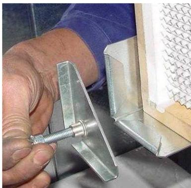
**Figura 163:** Inserire il dispositivo di serraggio
