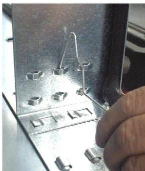
**Figura 150:** Inserire i dispositivi di fissaggio
