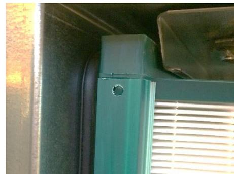
**Figura 160:** Controllare se il filtro poggia sul sigillo
