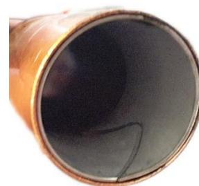
**Figura 177:** Tubo di rame con anello di rinforzo inserito
