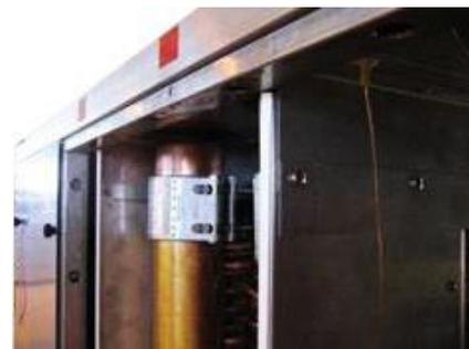
**Figura 179:** Giunto STRAUB montato
