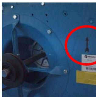
**Figura 207:** Marcatura senso di rotazione ventilatore dell'alloggiamento
