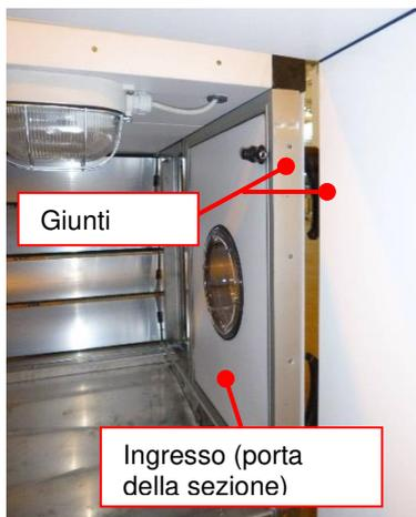
**Figura 101:** Divisione accessibile mediante porta dell'UTA
