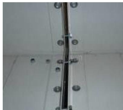
**Figura 71:** Collegamento con angolo di montaggio
