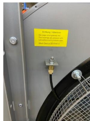
**Abbildung 23:** Ventilatorlager mit Schmiernippel
