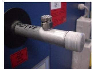
**Abbildung 14:** Entlüftungsventil
