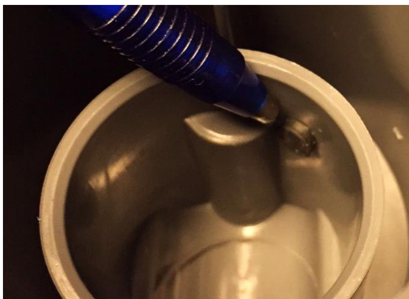
Figur 189: Trykksideinstallasjon: fjern den svarte lukkepluggen
