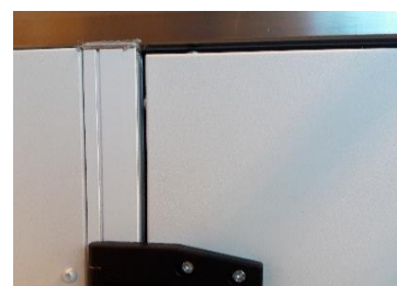
Figur 126: Justert - jevn spaltebredde (ZIS)
