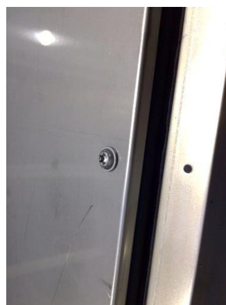
Figur 92: Det ytre panelet er skrudd fast
