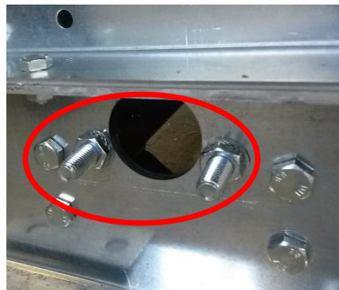
Figur 24: Fabrikkutført klargjøring av løftefester på monoblokk
