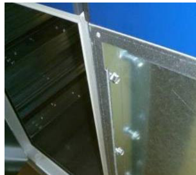
Figur 72: Forbindelse mellom dørkarm / internt panel
