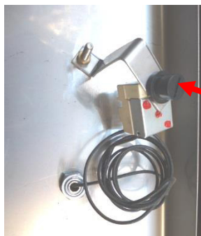
Figur 202: Termostat med deksel på tilbakestillingsknappen
