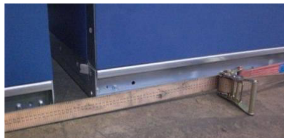
Figur 50: Trekk AHU-seksjoner sammen (detalj)
