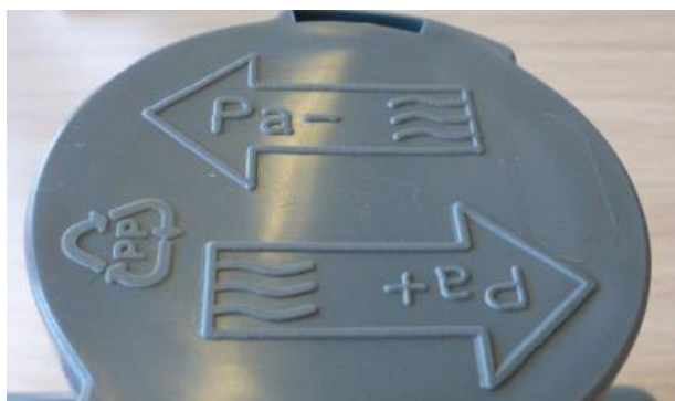
Figur 186: Pass på monteringsposisjonen - flytretning i samsvar med pilens retning
