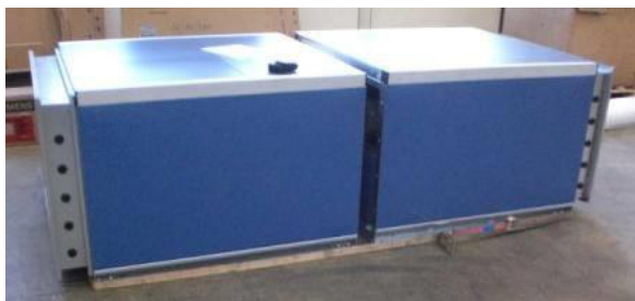
Figur 49: Trekk AHU-seksjonene sammen
