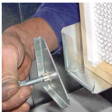
Figur 156: Sett inn klemmene
