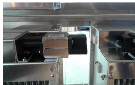
Figur 163: Tilkoblingsplugg for elektrostatiske filtre
