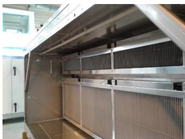
Figur 162: Elektrostatisk filtre i filterrammen
