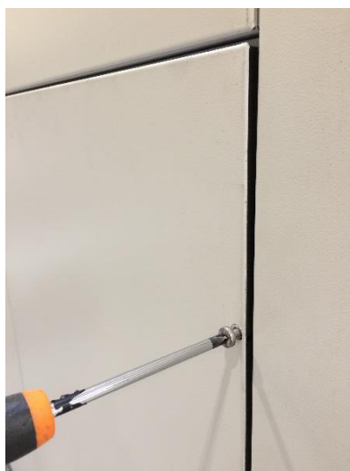
Figur 131: Løsne lukepanelet (TRA-E) fra lukerammen
