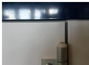
Figur 123: Justert - jevn spaltebredde (EU.T)
