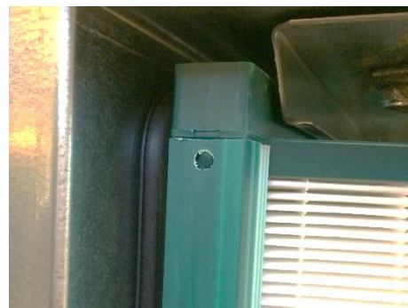
Figur 153: Sjekk om filteret ligger mot tetningen
