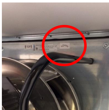
Figur 199: Rotasjonsmarkering av EC-vifter
