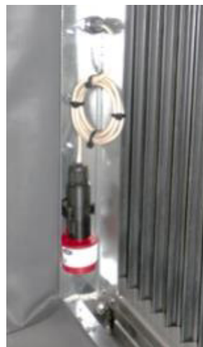
Figur 167: Montert gassdetektor
