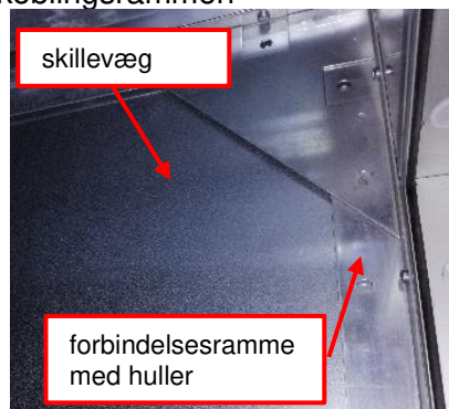
Figur 85: Koblingsramme og skillevegg (ikke skrudd ennå)
