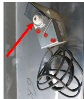
Figur 203: Termostat med tilbakestillingsknapp uten deksel
