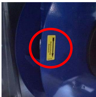
Figur 197: Rotasjonsmarkering på plug-in vifter
