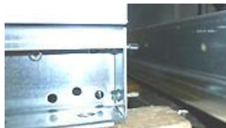
Figur 74: Bruk av selvtappende skruer
