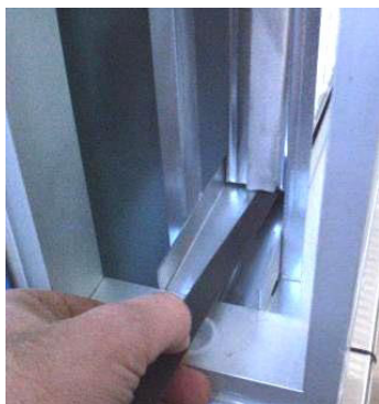
Figur 140: Udrækning af filtrene
