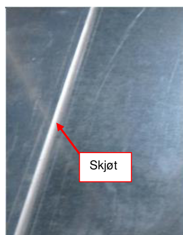
Figur 96: Tetning av seksjonsforbindelse (skjøt) med tetningsmiddel
