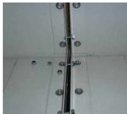
Figur 64: Forbindelse via forbindelsesvinkel
