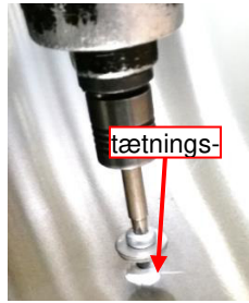
Figur 103: tetningsmiddel tatt i bruk (Sikaflex)
