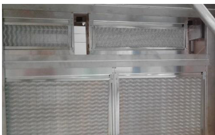
Figur 161: Montering av elektrostatisk filter
