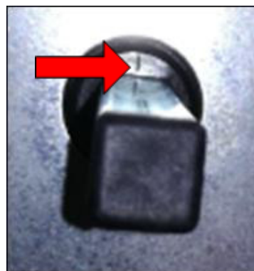
Figur 139: Lukket stilling, preget av en markering på giret
