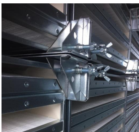
Figur 158: Filterstrammer med trykkplate
