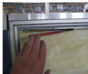
Figur 147: Sett klemmer på filtrene
