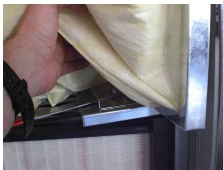
Figur 148: Løft filterposene
