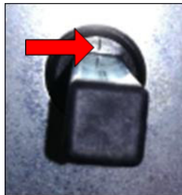
Ilustrație 138: Poziția închisă, caracterizată printr-un marcaj pe roata dințată
