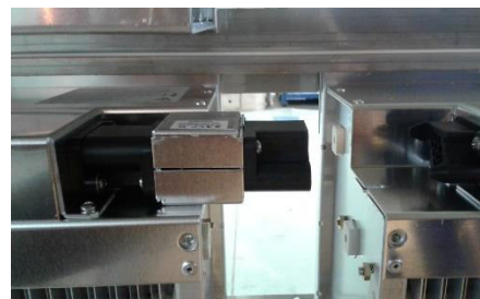
Ilustrație 162: Filtrele electrostatice cu conectare prin fișă
