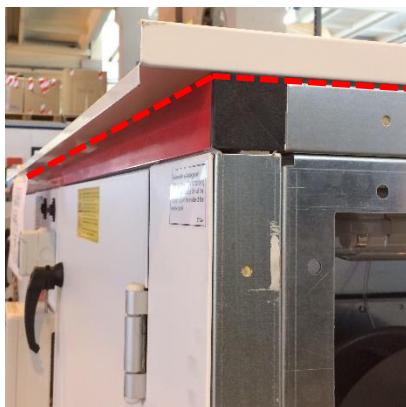
Ilustrație 104: Închiderea îmbinărilor cu etanșant
