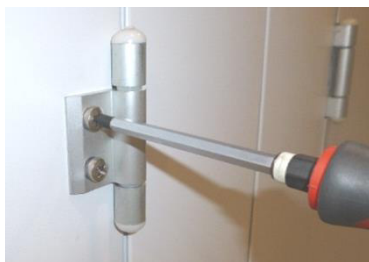
Ilustrație 121: Reglarea panoului de usa (EU.T)
