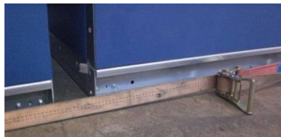
Ilustrație 50: Imbinarea secțiunilor AHU (detaliu)
