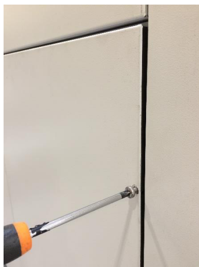
Ilustrație 130: Desfaceți panoul ușii (TRA-E) de la cadrul ușii
