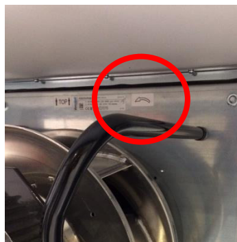
Ilustrație 196: Marcarea rotației la EC fans
