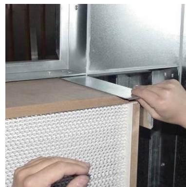
Ilustrație 154: Inserting the filter cell
