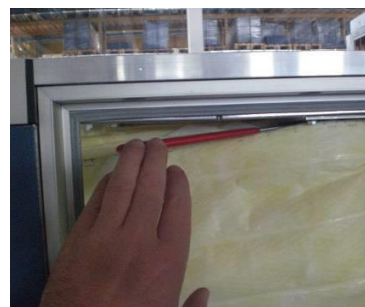
Ilustrație 146: Prinderea filtrelor
