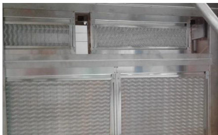
Ilustrație 160: Montarea filtrului electrostatic
