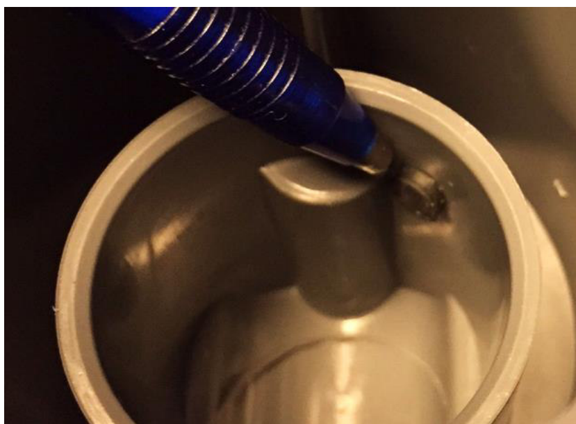
Ilustrație 186: Instalare pe partea de presiune: scoateți dopul de închidere negru
