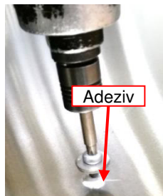
Ilustrație 102: Sigilant aplicat (Sikaflex)
