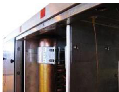
Ilustrație 171: Cuplaj STRAUB montat
