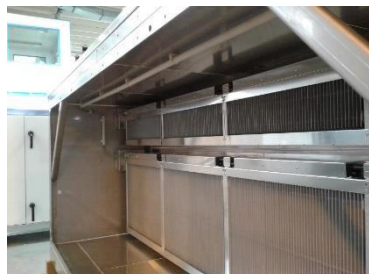
Ilustrație 161: Filtre electrostatice în cadrul filtrului
