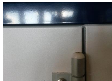
Ilustrație 122: Reglat – latime constanta a fantei (EU.T)
