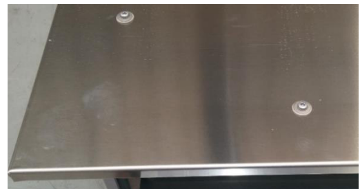
Ilustrație 103: Acoperiș din tablă metalică
