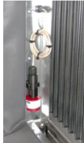
Ilustrație 166: Detector de gaz montat
