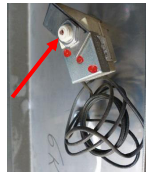
Ilustrație 200: Termostat cu buton de reset neacoperit
