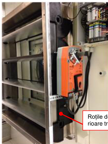
Ilustrație 163: Damper cu roți dințate exterioare
