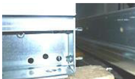
Ilustrație 73: Aplicarea șuruburilor autofiletante
