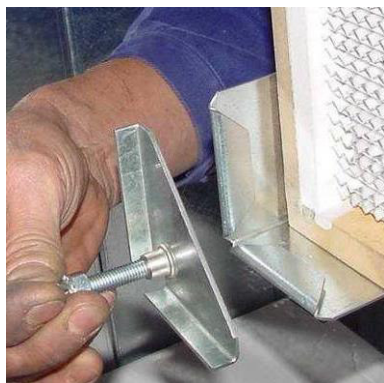
Ilustrație 155: Inserting the clamps
