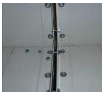
Ilustrație 64: Conectare cu colțar
