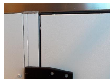
Ilustrație 125: Reglat – latime constanta a fantei (ZIS)
