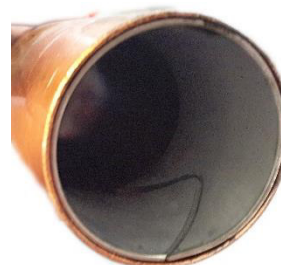
Ilustrație 169: conducta de cupru cu inel de armare introdus
