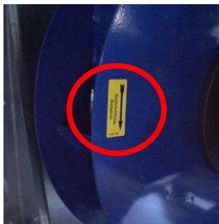
Ilustrație 194: Marcarea sensului de rotație la ventilatoarele cu cuplaj direct
