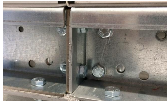
Ilustrație 57: Conectarea cu șurub a cadrului de bază
