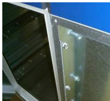
Ilustrație 71: Conexiune între cadrul ușii / panoul intern
