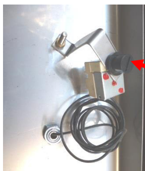
Рисунок 72: Термостат с крышкой на кнопке сброса
