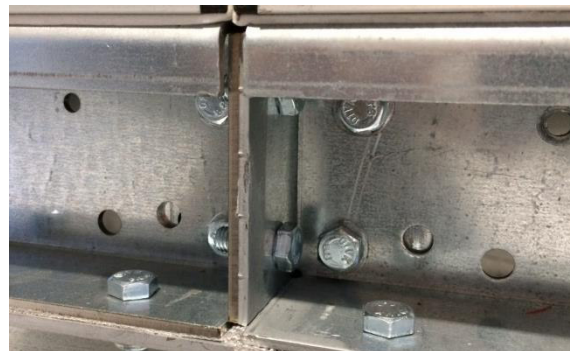
Рисунок 25: Болтовое соединение опорных рам
