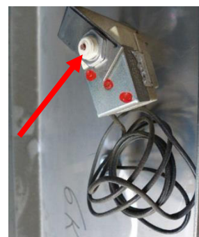
Рисунок 73: Термостат с открытой кнопкой сброса
