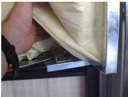
Рисунок 47: Поднятие фильтровальных мешков
