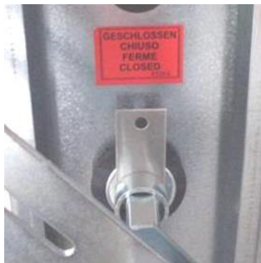
Рисунок 42: на закрытое положение указывает индикатор положения из листового металла
