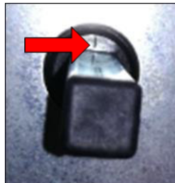
Рисунок 43: на закрытое положение указывает маркировка на шестерне
