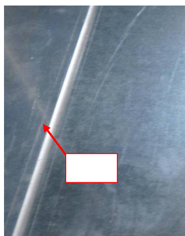
Рисунок 36: Уплотнение соединения секции (стыка) герметиком
