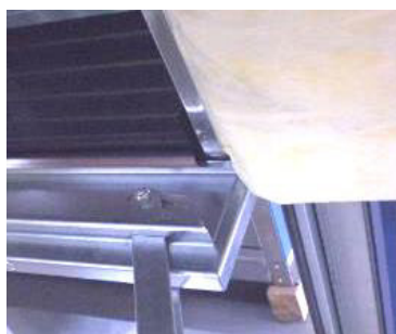
Рисунок 45: Задвиньте фильтры
