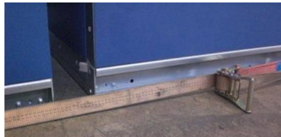
Рисунок 23: Объединение секций СКВ(детали)
