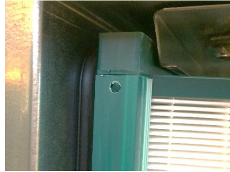
Рисунок 52: проверьте, лежит ли фильтр на уплотнении
