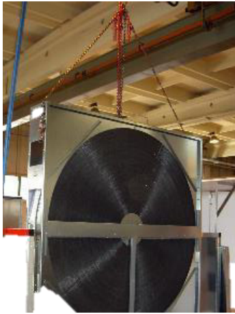
Рисунок 81: Подъем с помощью цепной тали
