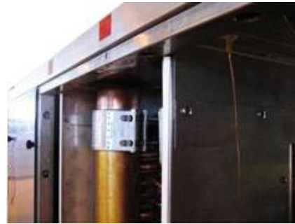
Рисунок 60: смонтированная муфта STRAUB
