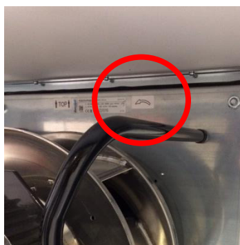
Рисунок 70: Маркировка вращения эл.-ком. вентиляторов
