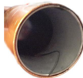
Рисунок 58: медная труба со вставленным усиливающим кольцом
