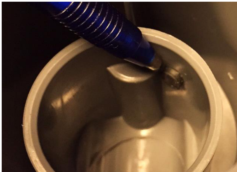
Рисунок 68: Установка со стороны давления: снимите черную заглушку
