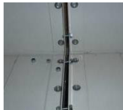
Рисунок 30: Соединение через угол соединения
