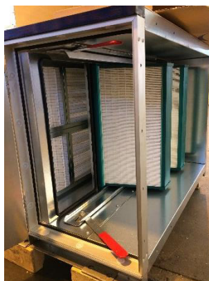
Рисунок 49: рассмотрите порядок согласования раstra кадра фильтра
