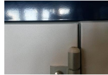
Рисунок 123: отрегулированная-постоянная ширина щели(EU.T)
