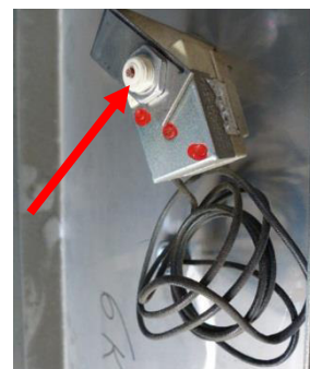
Рисунок 203: Термостат с открытой кнопкой сброса
