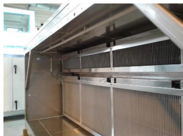
Рисунок 162: Электростатические фильтры в рамке
