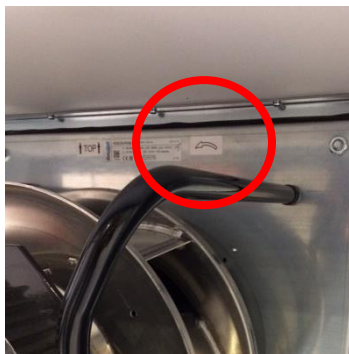
Рисунок 199: Маркировка вращения эл.-ком. вентиляторов
