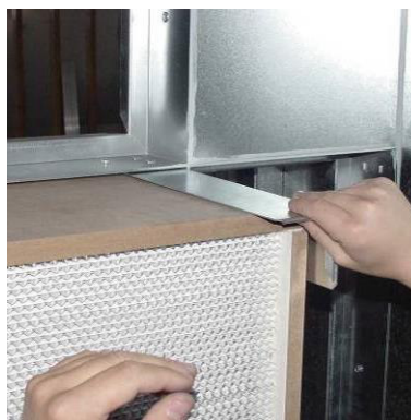
Рисунок 155: Вставка ячейки фильтра
