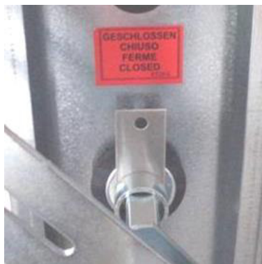
Рисунок 138: на закрытое положение указывает индикатор положения из листового металла
