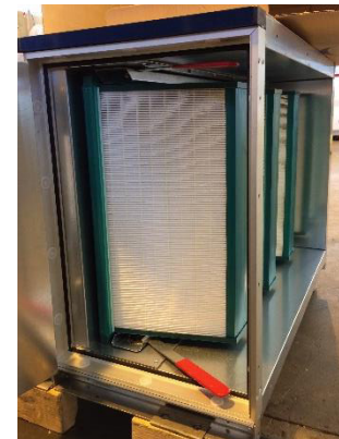
Рисунок 151: секция фильтра со встроенными фильтрами
