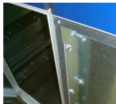
Рисунок 72: Соединение между дверной рамой и внутренней панелью
