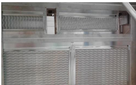
Рисунок 161: Монтаж электростатического фильтра
