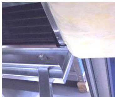
Рисунок 146: Задвиньте фильтры
