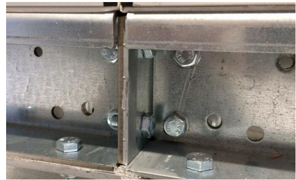
Рисунок 57: Болтовое соединение опорных рам
