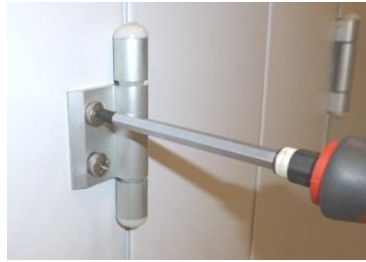
Рисунок 122: регулировка дверной панели (EU.T)
