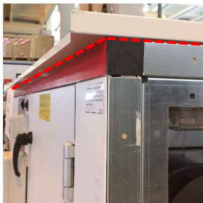
Рисунок 105: Закрытие стыков герметиком
