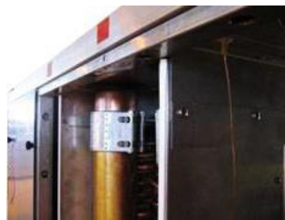
Рисунок 172: смонтированная муфта STRAUB
