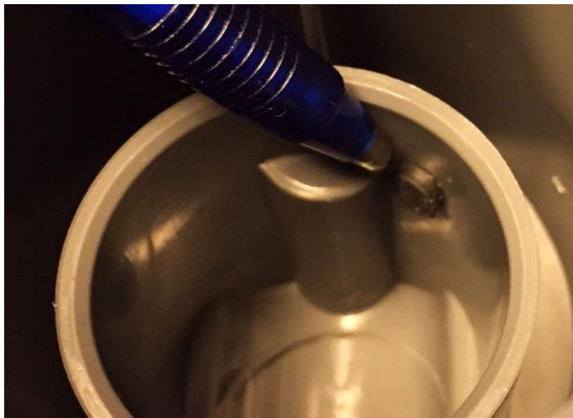
Рисунок 189: Установка со стороны давления: снимите черную заглушку
