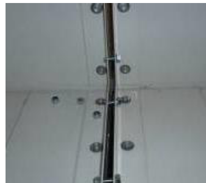
Рисунок 64: Соединение через угол соединения
