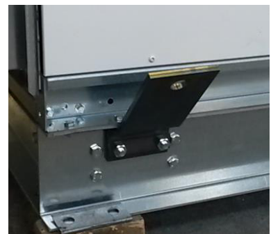
Рисунок 27: Моноблочный кран подъемные проушины установлены
