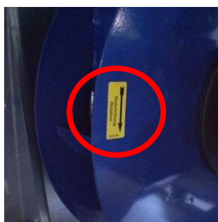
Рисунок 197: Маркировка вращения штепсельных вентиляторов
