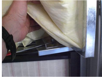
Рисунок 148: Поднятие фильтровальных мешков
