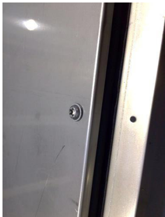
Рисунок 52: Монтаж внешних панелей
