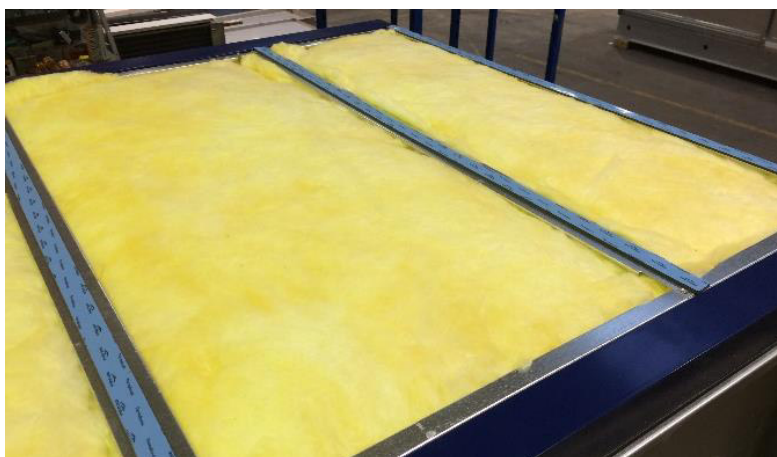
Рисунок 101: Часть СКВ подготовлена к сборке кровли из металлических листов
