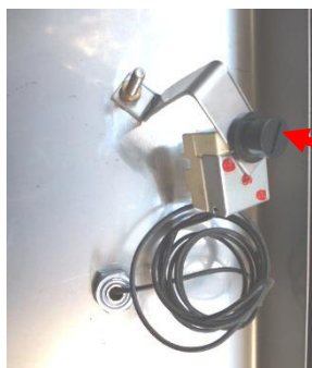
Рисунок 202: Термостат с крышкой на кнопке сброса
