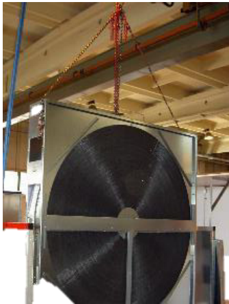
Рисунок 238: Подъем с помощью цепной тали
