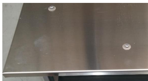
Рисунок 104: Смонтированная крыша из металлического листа
