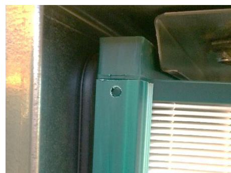
Рисунок 153: проверьте, лежит ли фильтр на уплотнении
