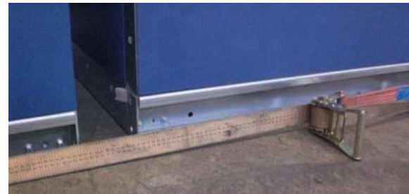
Рисунок 50: Объединение секций СКВ(детали)
