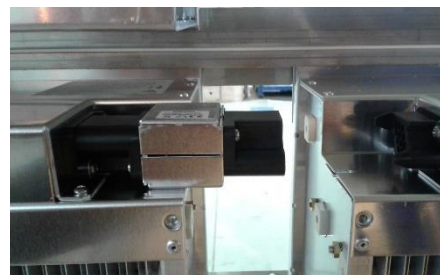
Рисунок 163: Электростатические фильтры со штекерным соединением
