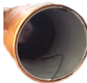
Рисунок 170: медная труба со вставленным усиливающим кольцом
