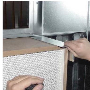
**Figura 157:** Insertando la celda de filtrado
