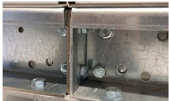
**Figura 60:** Conexión con tornillos al bastidor
