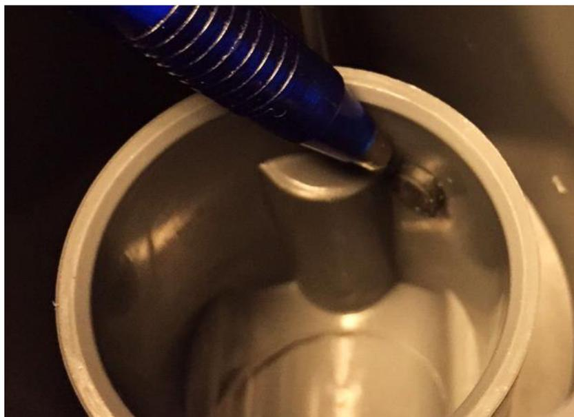
Figura 193: Instalación del lado de presión: quite el enchufe de cerrado negro
