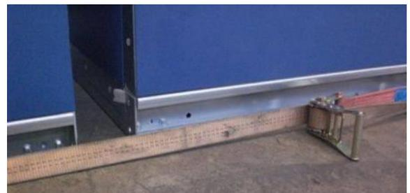
**Figura 53:** Juntando las secciones de la UTA (detalle)
