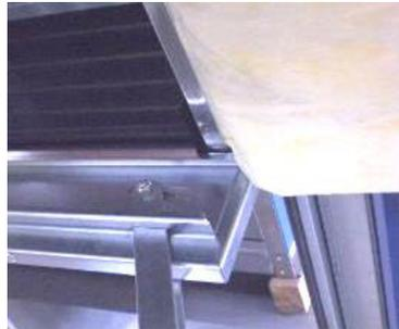
**Figura 148:** Deslizando los filtros
