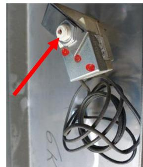
**Figura 207:** Termostato con el botón de reinicio al descubierto
