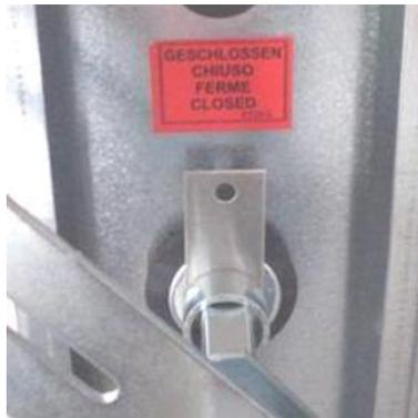
**Figura 140:** Posición cerrada, caracterizada por un indicador de posición de chapa
