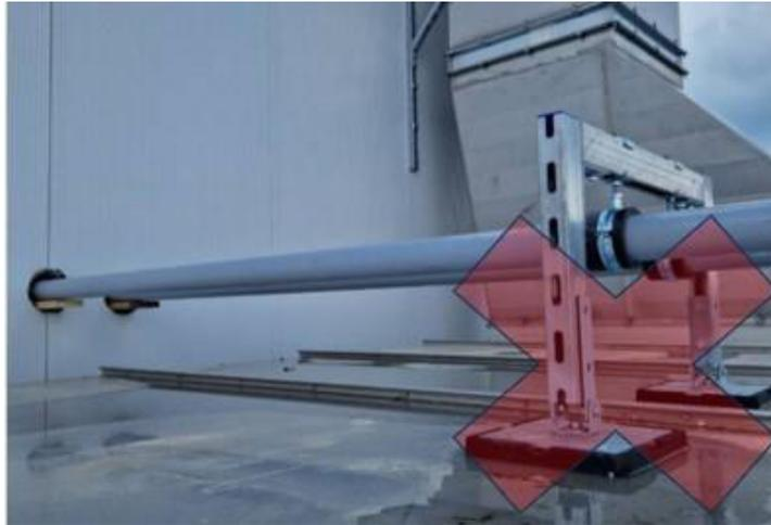
**Figura 36:** Tuberías inadecuadas en el sitio
