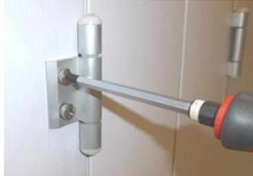
**Figura 124:** Ajuste del panel de la puerta (EU. T)
