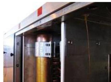
**Figura 174:** Acoplamiento STRAUB instalado
