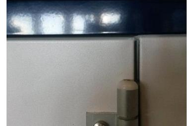
**Figura 125:** Ajustado – ancho de la apertura constante (EU. T)
