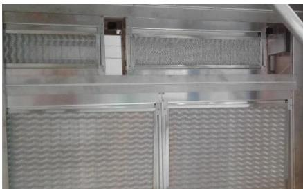
**Figura 163:** Montaje de filtro electrostático
