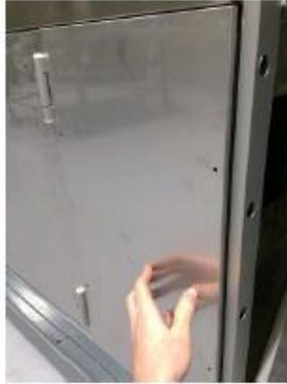
**Figura 57:** Paneles externos con tornillos no atornillados
