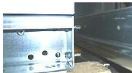
**Figura 76:** Uso de tornillos autorroscantes
