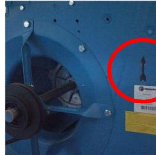
**Figura 202:** Marca de rotación de ventiladores con carcasa
