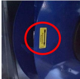
**Figura 201:** Marca de rotación de ventiladores plug-fan
