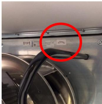
**Figura 203:** Marca de rotación de ventiladores EC
