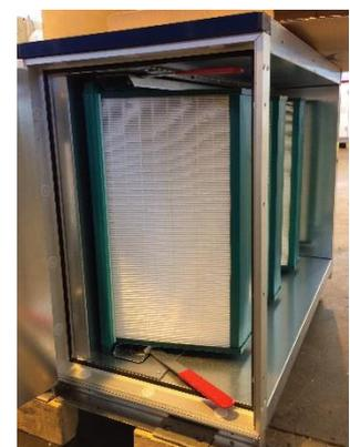
**Figura 153:** Sección de filtrado con filtros insertados de filtrado
