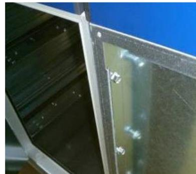
**Figura 74:** Conexión entre marco de la puerta/panel
