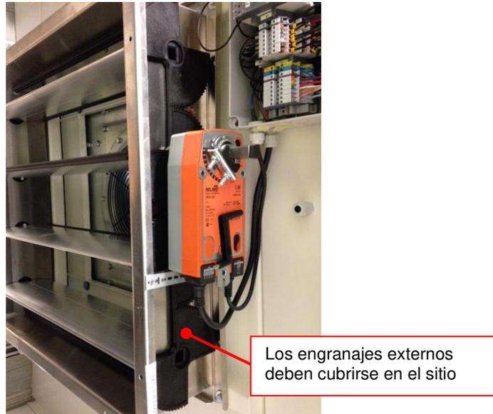
**Figura 166:** Amortiguador con una rueda de engranaje externa
