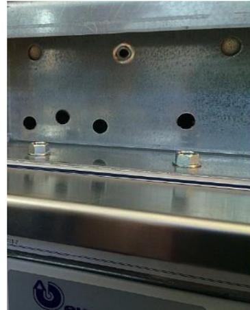
**Figura 85:** Conexión de dos unidades una encima de la otra
