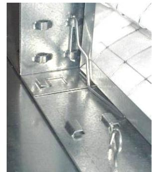
**Figura 146:** Filtro fijado
