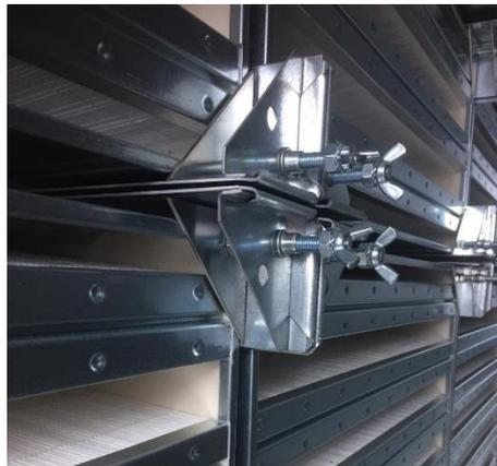
**Figura 160:** Tensor de filtro con placa de presión
