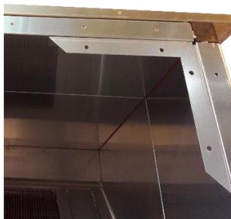
Figura 66: Conexión angular
