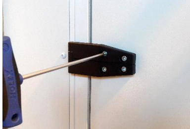
Resim 124: Kapı panelinin konumunun ayarlanması (ZIS)
