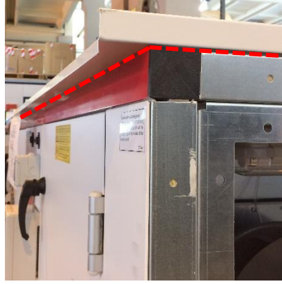
Resim 104: Birleşme yerlerinin mastikle kapatılması
