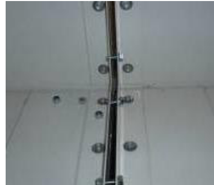
Resim 64: Bağlantı pekiştirme köşebentisiyle bağlama
