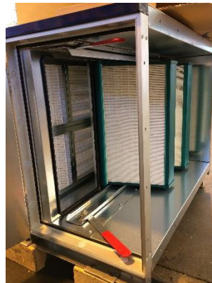
Resim 149: Filtrelerin takılma sırası filtre çerçevesinin ızgarasına uygun olmalıdır
