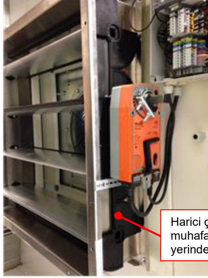
Resim 163: Harici dişli çarklı damperler
