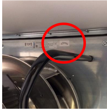
Resim 198: EC fanların dönüş yönü işareti
