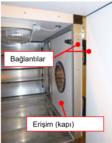
Resim 94: Kapı vasıtasıyla erişilen bölüm
