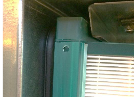
Resim 152: Filtre contaya yapışık olmalıdır
