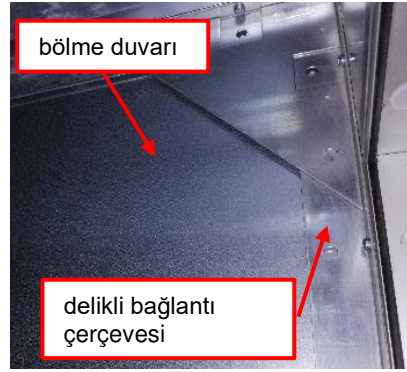
Resim 84: Bağlantı çerçevesi ve bölme duvarı (henüz vidalanmamış)
