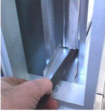
Resim 139: Filtrelerin çekilerek çıkarılması
