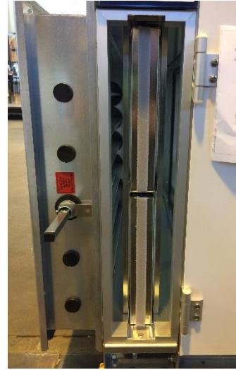
Resim 128: Çıkarılmış kapı paneli (TRA)
