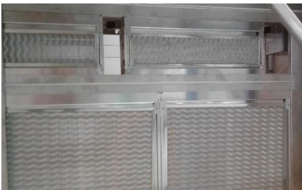
Resim 160: Elektrostatik filtre montajı
