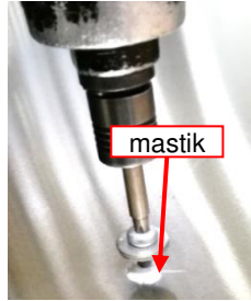
Resim 102: Mastik (Sikaflex) uygulaması
