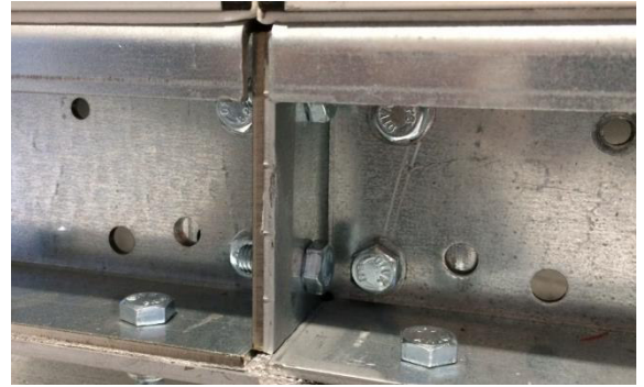
Resim 57: Taban çerçevesinin cıvatalanması
