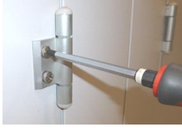
Resim 121: Kapı panelinin konumunun ayarlanması (EU.T)
