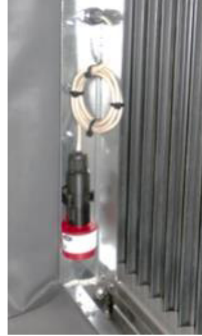
Resim 166: Monte edilmiş gaz dedektörü
