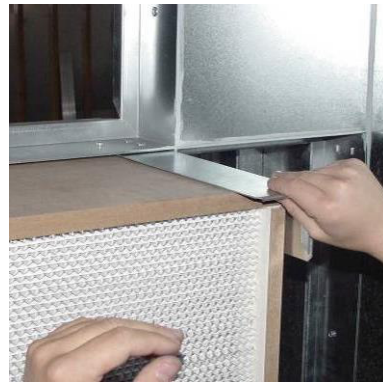
Resim 154: Filtre hücresinin takılması
