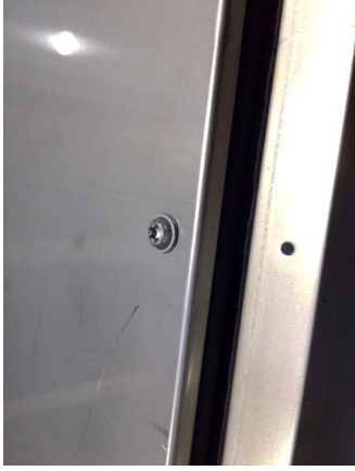
Resim 53: Dış panellerin yerleştirilmesi
