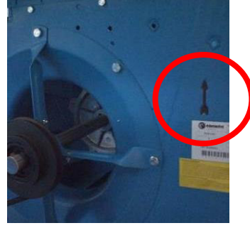
Resim 197: Muhafazalı fanların dönüş yönü işareti
