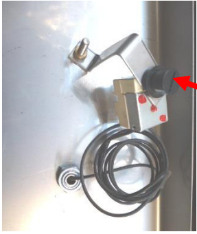
Resim 201: Termostat ve reset düğmesinin kapağı
