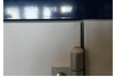
Resim 122: Ayarlanmış - aralık açıklığı sabit (EU.T)
