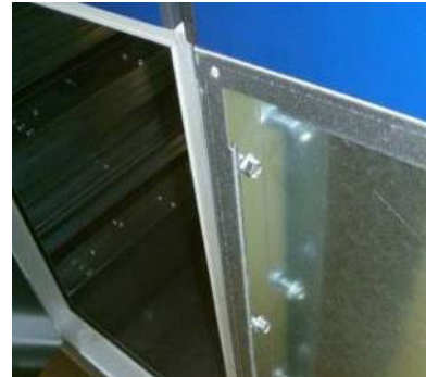
Resim 71: Kapı çerçevesi / iç panel bağlantısı
