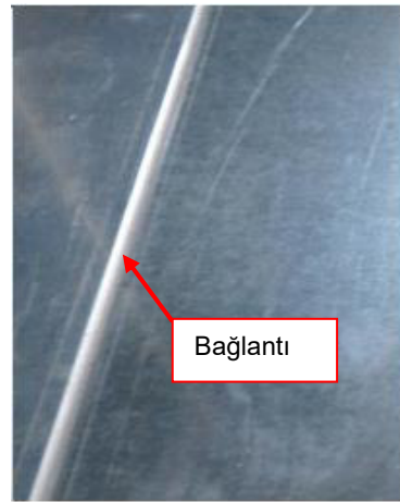
Resim 95: Bölümün bağlantısının sızdırmazlık mastiğiyle kapatılması
