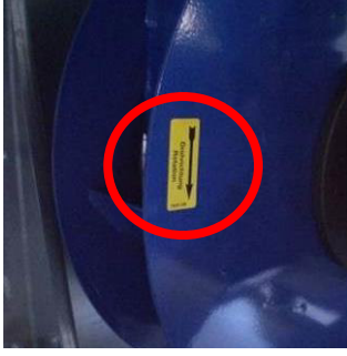
Resim 196: Plug fanların dönüş yönü işareti
